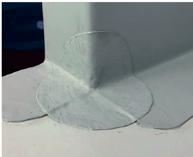
Рисунок 13. (гидроизоляция внешнего угла)
