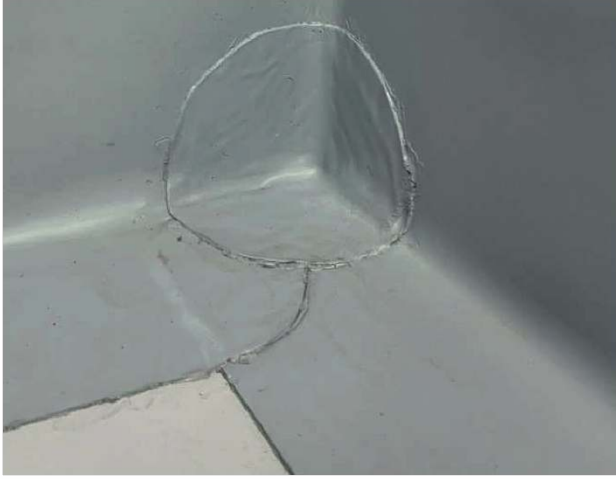
Рисунок 15. (гидроизоляция внутренний угол)
